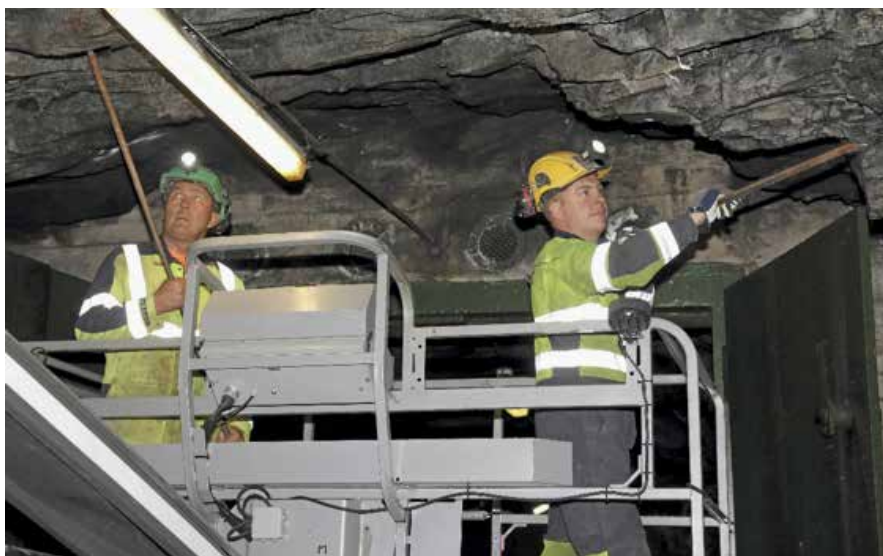
Tunnelarbeid kan være risikofylt. Arbeidet må planlegges godt og nødvendige tiltak iverksettes for å unngå ulykker. Her forestår Jan Agnar Trengereid (t.h.) og Arne Langedal tunnelrensing. (Foto: Jarle Hodne)
